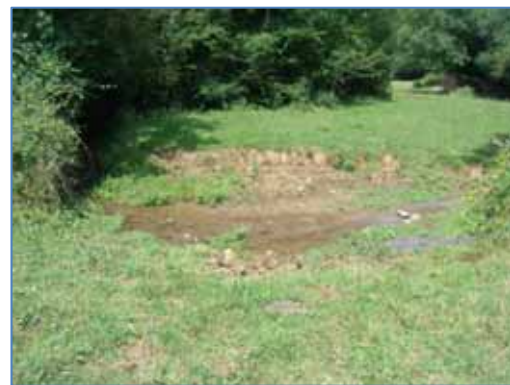
Secteur piétiné sur la Clôture
