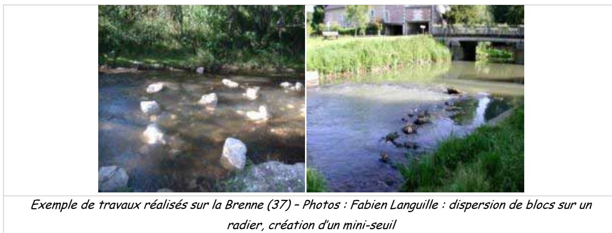
Reméandrage à long terme du cours d'eau rectifié par l'utilisation de déflecteurs en matériaux naturels (pierres, bois, fascines, etc.).
