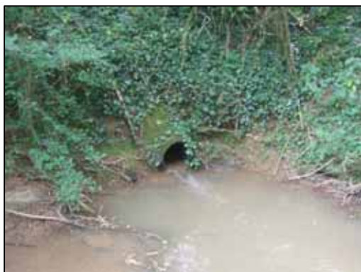
Passage busé sous-dimensionné de la Couture sur la Couture
